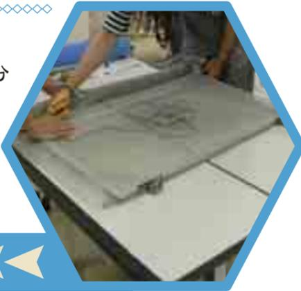
3. クリップでとめた反対側からゴムの端を長辺部角の溝にローラーのヘラの部分でL型に押し込み、網を止める。
