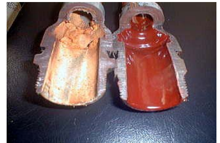
（写真：排水管的の更新前（左）と更新後（右））
