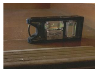
建物の傾き状況を水平器で測定
