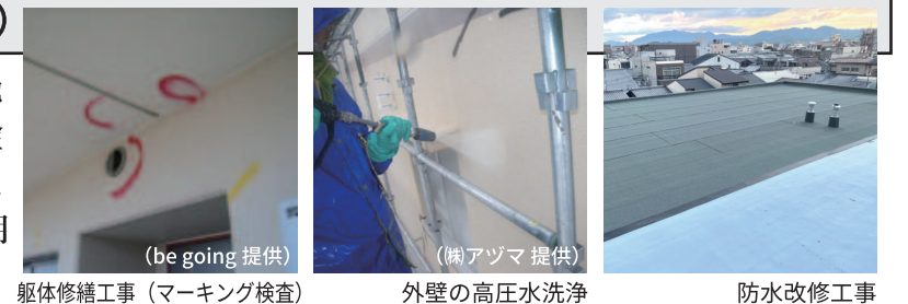
躯体修繕工事(マーキング検査)
