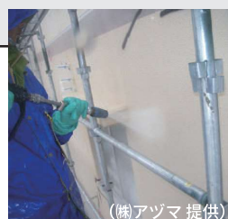
外壁の高圧水洗浄 (株)アツマ 提供
