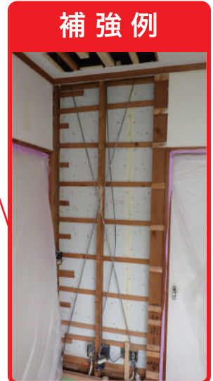
補強例 ステンレス製補強金物 壁をステンレス製補強金物で補強しました。
