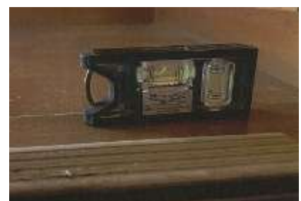
建物の傾き状況を水平器で測定
