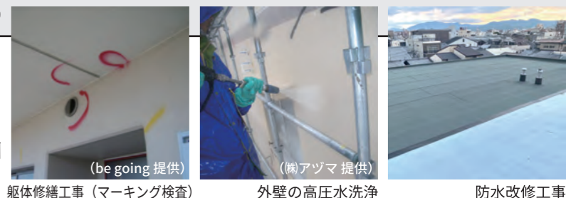
躯体修繕工事(マーキング検査)
