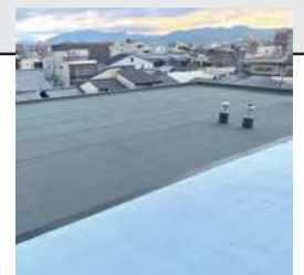
防水改修工事
