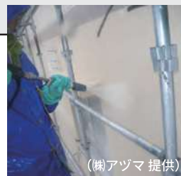
外壁の高圧水洗浄 (㈱アツマ 提供)
