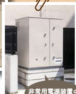
非常用電源装置のかさ上げ
