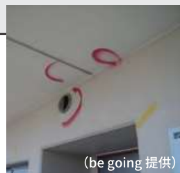
躯体修繕工事（マーキング検査） (be going 提供)
