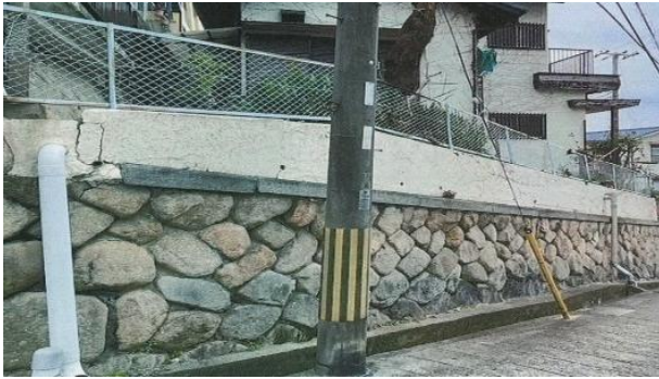
土留めを兼ねているコンクリート塀
